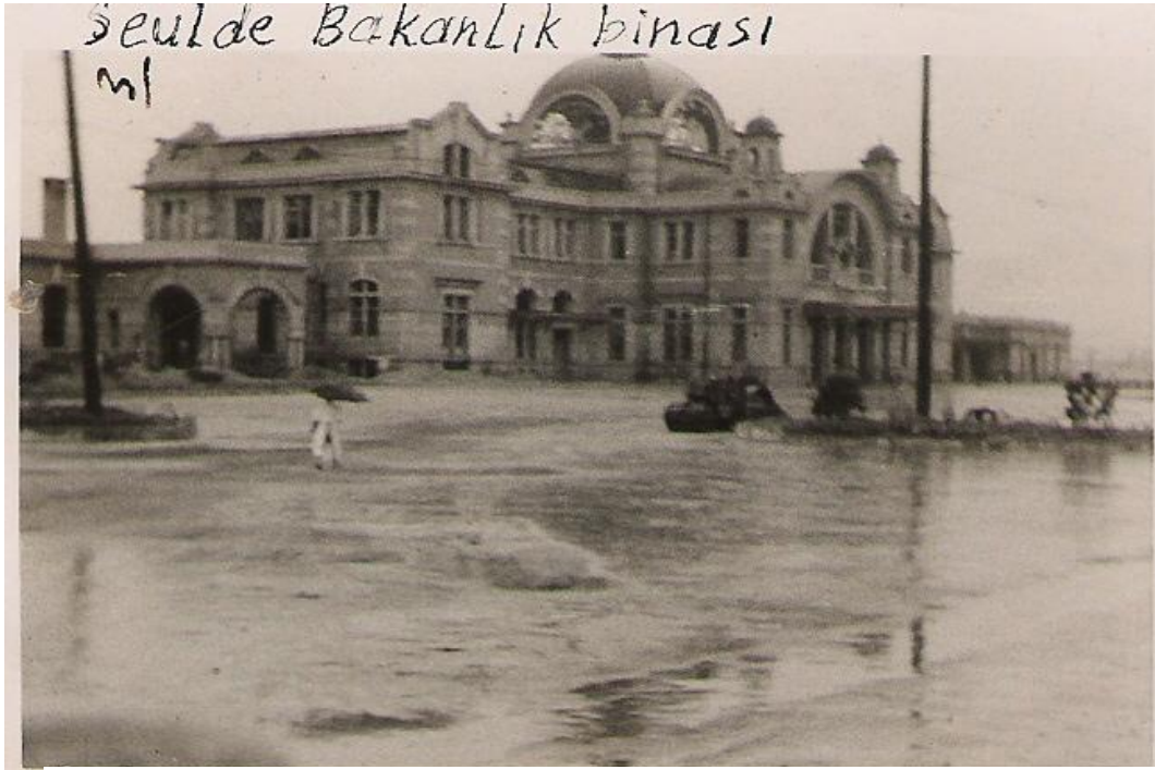
Seul'deki bakanlık binası sağlam kalmış ne bir kapı ne de bir pencere var
